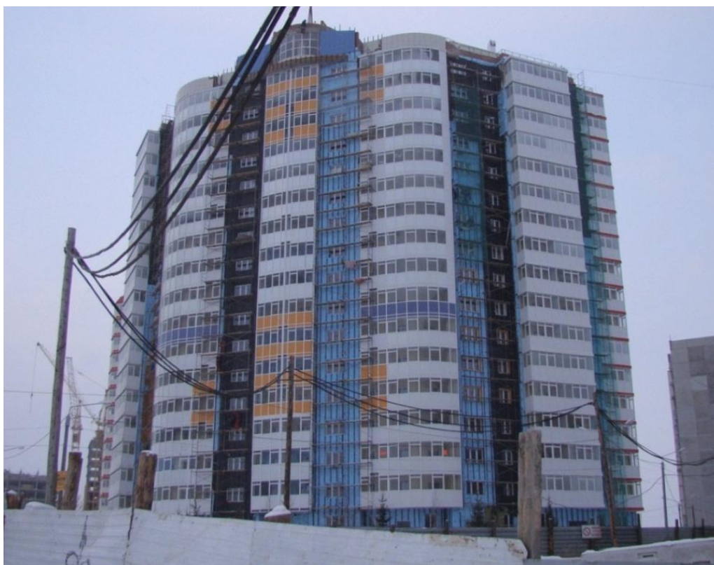
Рис. 14 Общий вид исследуемого здания
