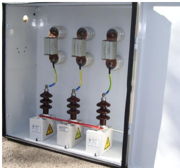
Рисунок 10 – Внешний вид RC-гасителя с выносным блоком сопротивлений
