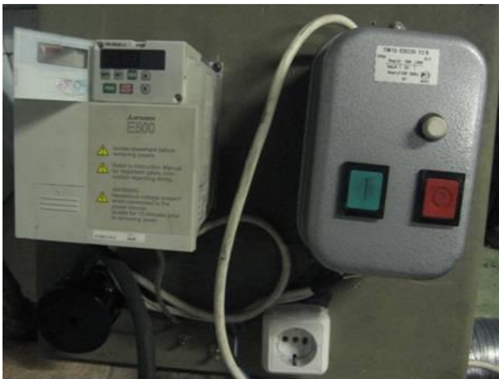
Рисунок 2.13 - Частотный преобразователь системы включения АГО-2С
