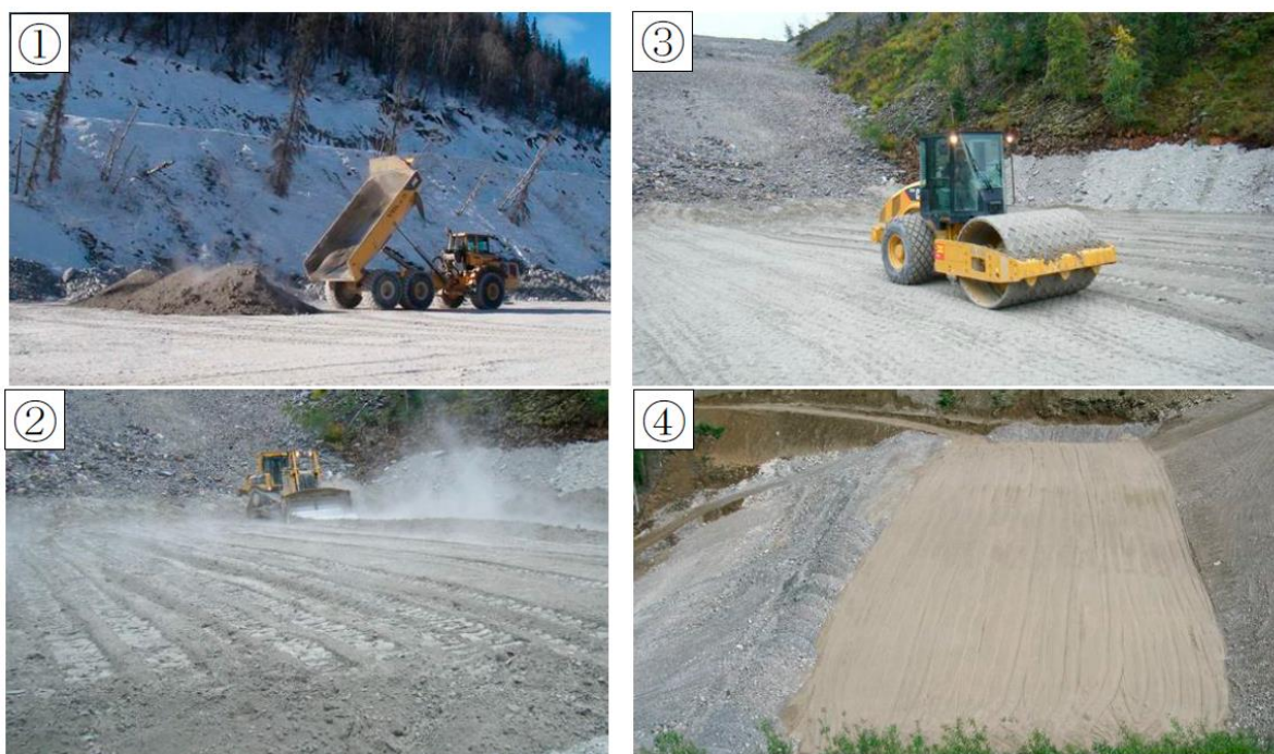
Рисунок 1.13 – Складирование «сухих» отходов обогащения при помощи автотранспорта на золоторудном месторождении Pogo Mine, Аляска [68]:
