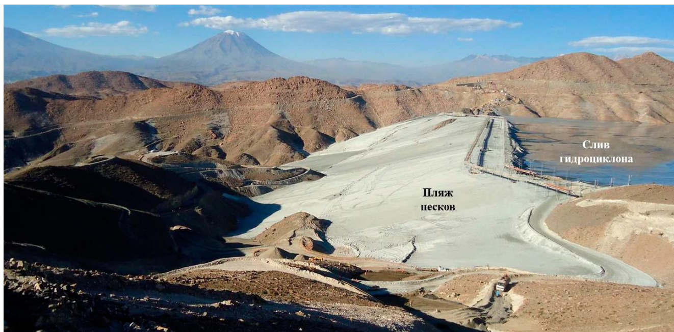
Рисунок 1.8 – Общий вид хвостохранилища Cerro Verde, Перу [48]
