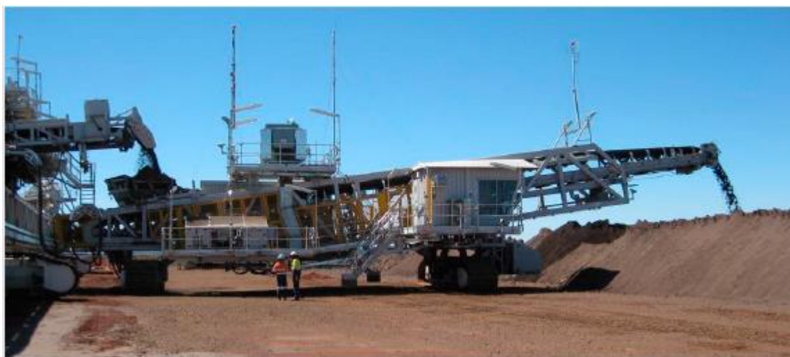
Рисунок 1.14 – Складирование «сухих» отходов мобильный конвейером, La Coira, Атаками, Чили [69]
