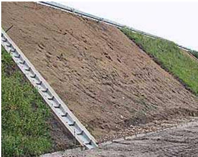
Рисунок 5.35 – Рекультивация поверхности откосов с использованием георешетки: а – вид георешетки; б – георешетка на склоне; в – заполнение георешетки грунтом; г – георешетка заповенная грунтом; д – лесопосадки в георешетке
