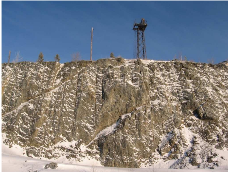
Рисунок 5.5 – Вид откоса, сформированного контурным взрыванием методом предварительного щелеобразования в сланцах 50 лет назад
