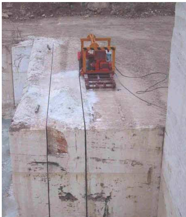
Рисунок 5.14 – Нарезка 10-метрового уступа при разработке месторождения травертина
