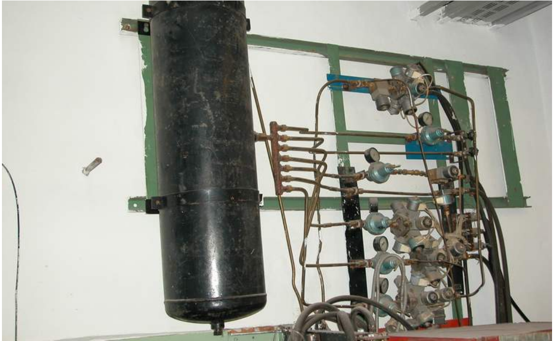
Рисунок 2.6 - Станция распределения газов УДГН «Катунь М»
