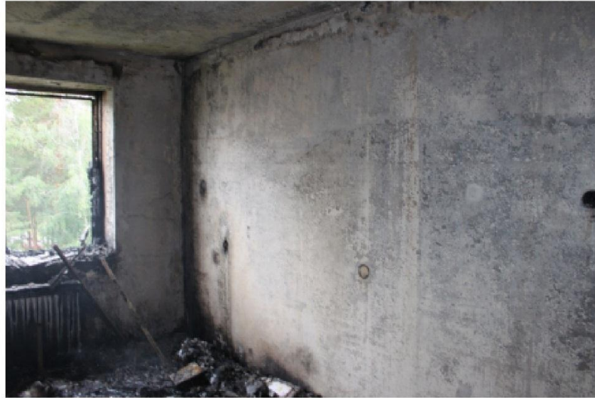
Рисунок 9 – Представленная для измерений бетонная стена
