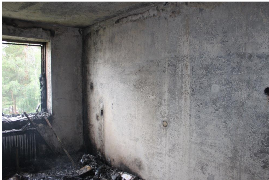
Рисунок 4.1 – Представленная для измерений бетонная стена
