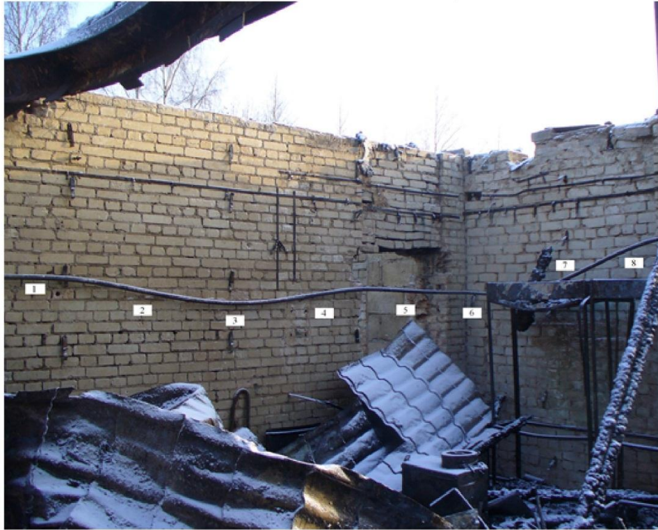
Рисунок 12 – Вид трубы и точек измерения в комнате жилого дома
