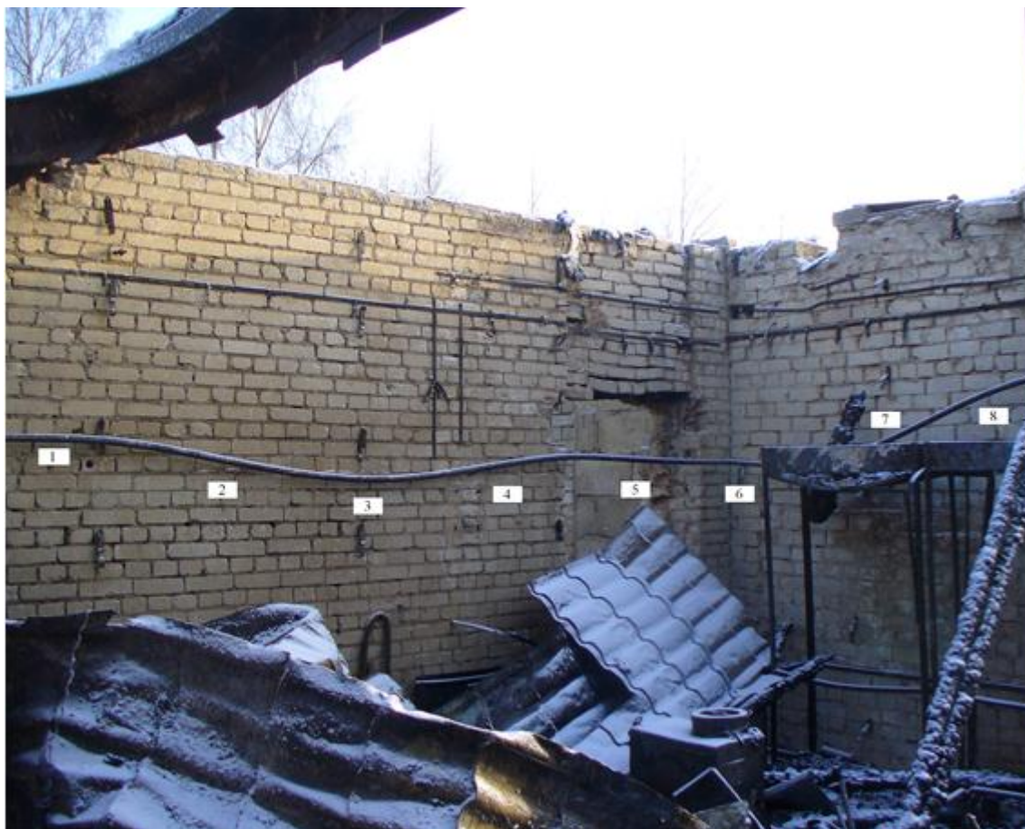
Рисунок 4.6 – Вид трубы и точек измерения в комнате жилого дома
