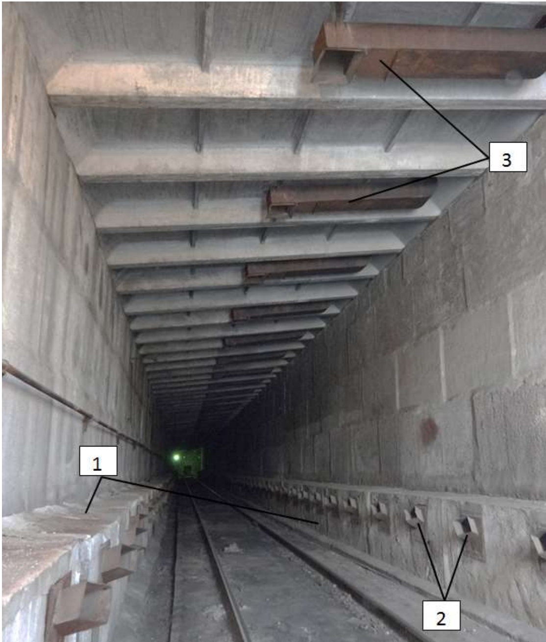
Рис. 1.12. Размораживающее устройство конвективного типа Владивостокской ТЭЦ-2
