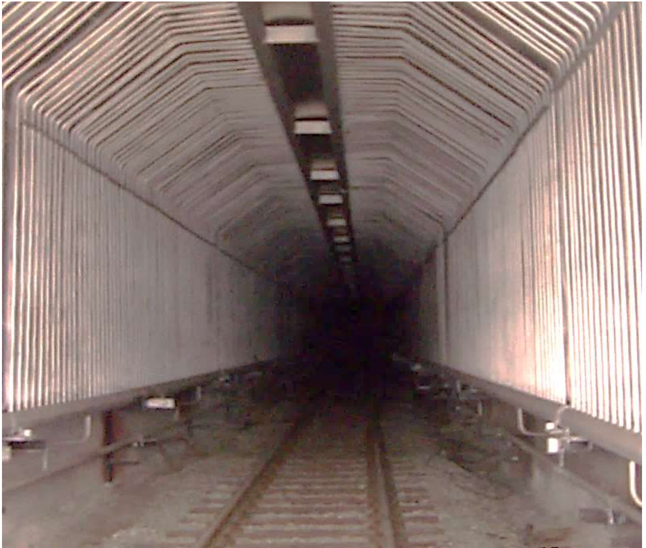
Рис. 2.7. Общий вид нагревательных экранов размораживающего устройства после модернизации
