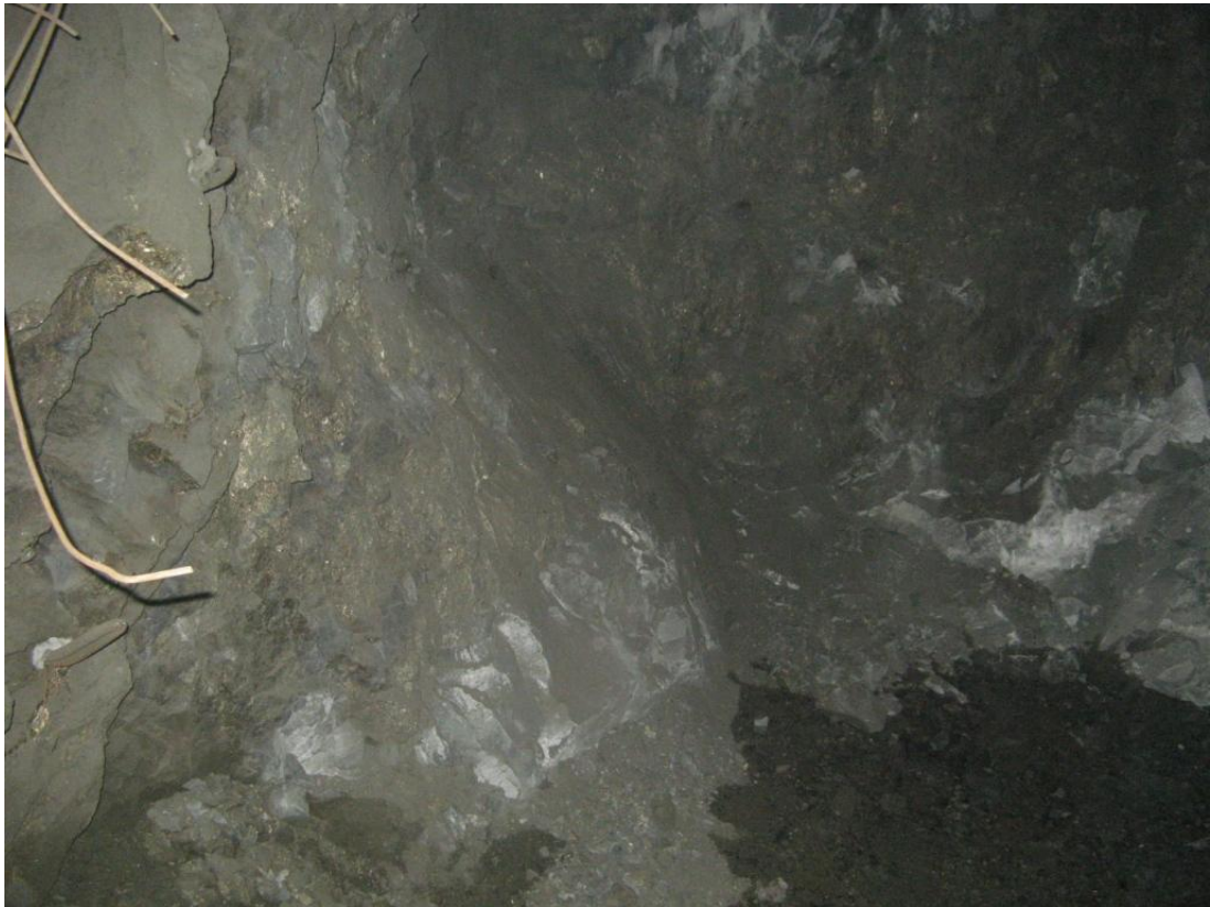
Рисунок 1.4 – Нижняя часть забоя после взрыва в выработке РО 21
