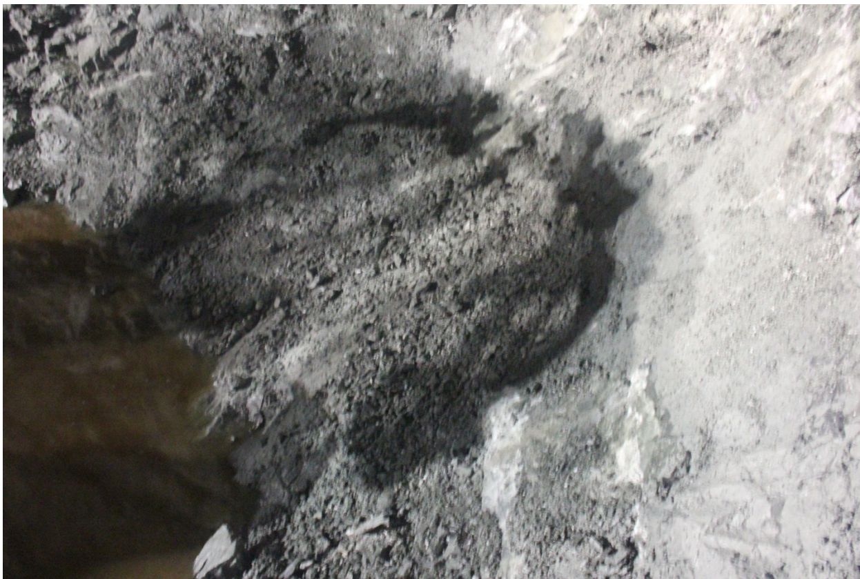
Рисунок 1.9 – Непроработанный уступ по почве выработки НРШК 52 п 7
