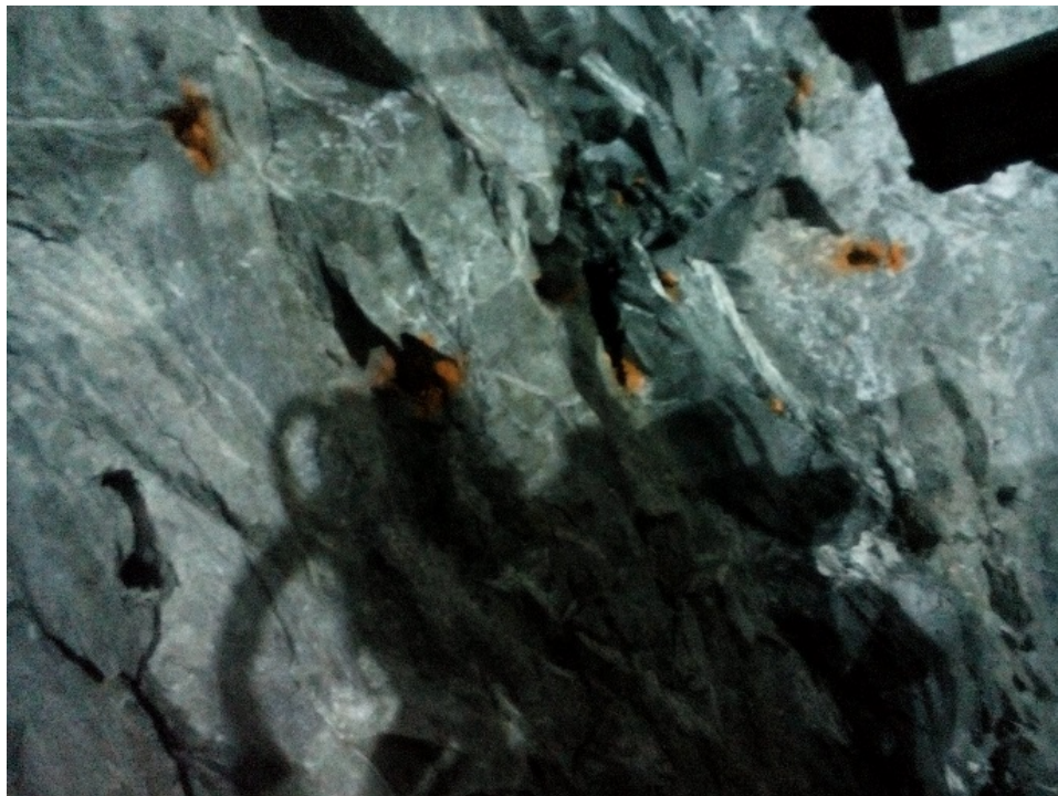
Рисунок 3.24 – Факт выполнения буровых работ в выработке РШ 1-43
