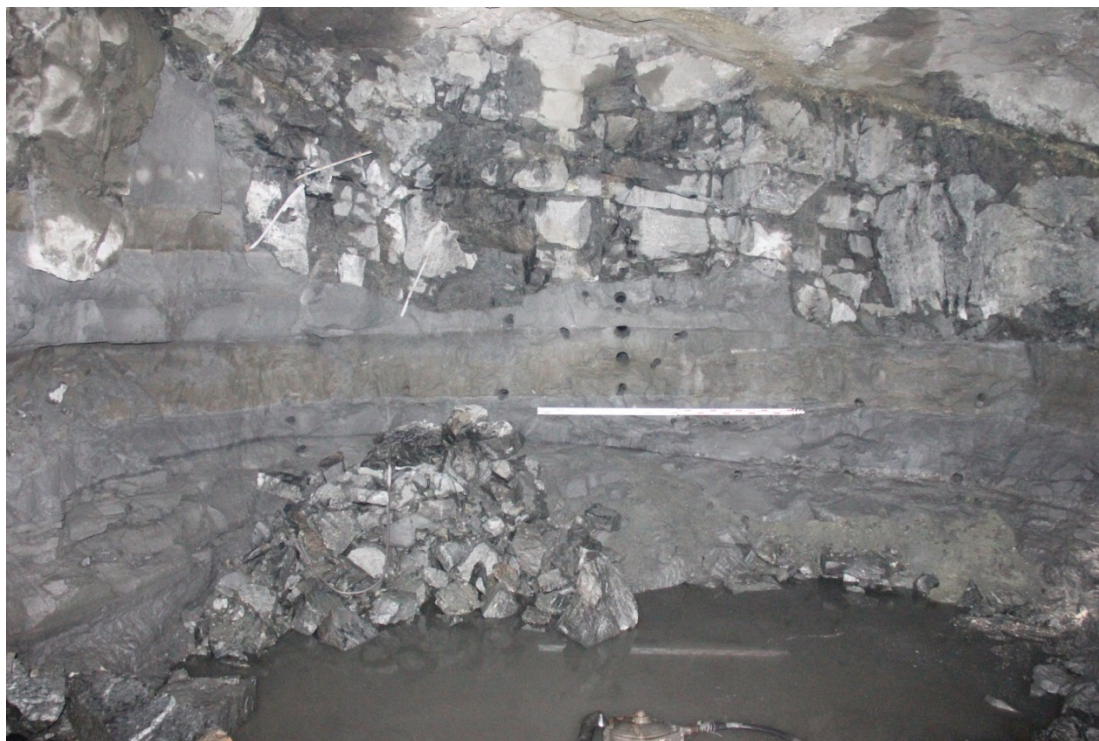
Рисунок 3.20 – Вид забоя выработки, в которой проводился опытный взрыв
