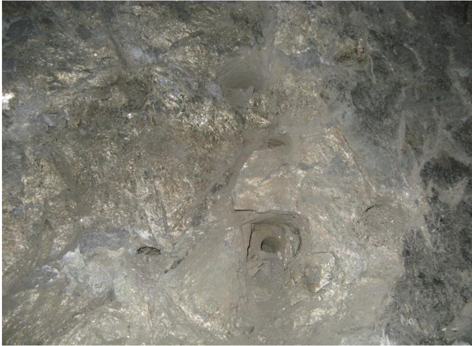
Рисунок 1.6 – Недобур расширителем компенсационной скважины в выработке ТШ л 35
