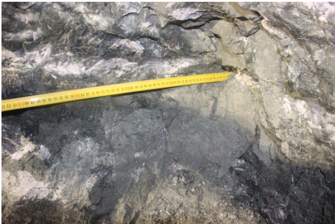
Рисунок 1.8 – Средняя величина «стаканов» в выработке НРШК 50 п 4
