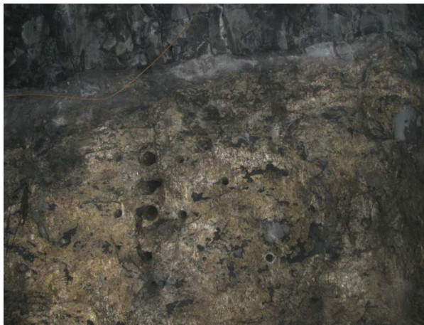
Рисунок 3.22 – Факт выполнения буровых работ в выработке РШ к.51 п 7:
