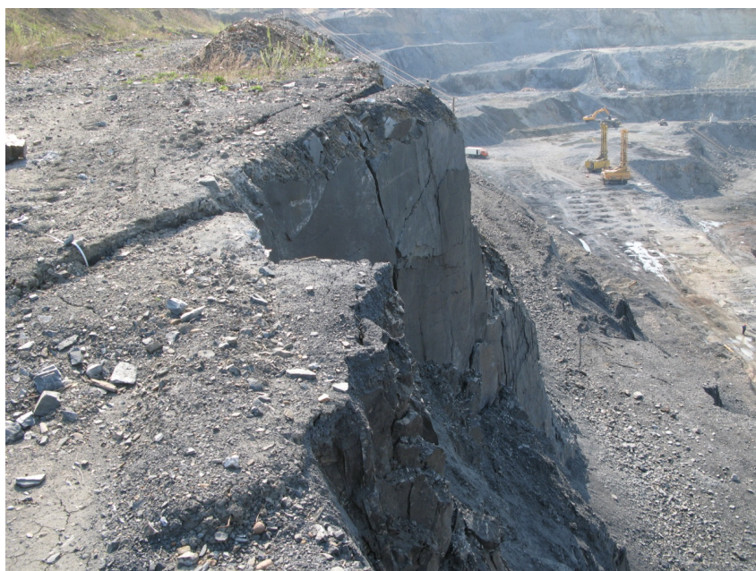
Рисунок 7 – Заколы после обрушения пород на горизонте +85м
