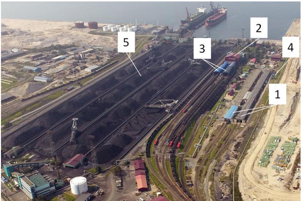
1- размораживающие устройства №1÷4 комбинированного типа; 2 -вагоноопрокидыватель №1,2; 3- размораживающие устройства №1,2 радиационного типа; 4 - устройство вибрационной очистки вагонов; 5 - основной склад угля.
