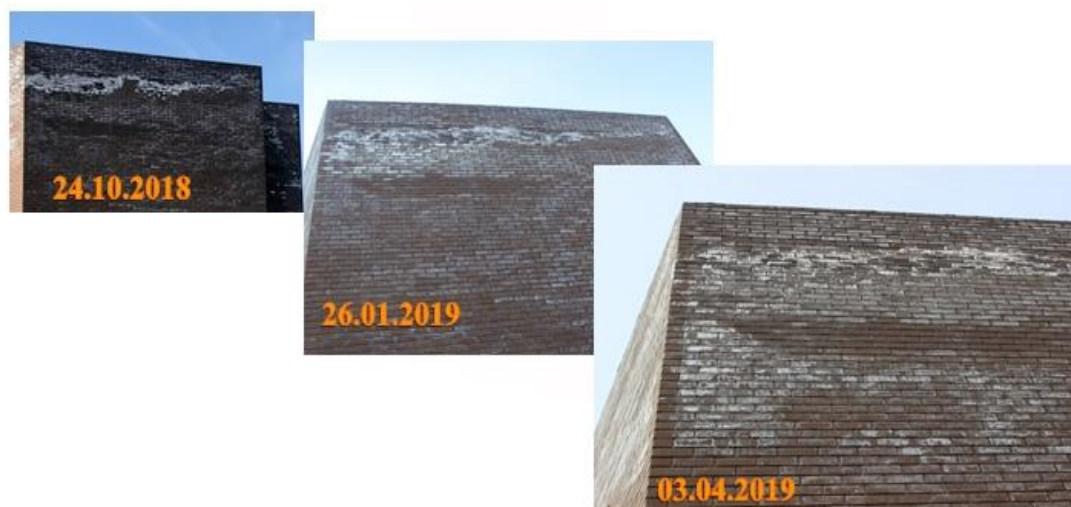
Рис. 3. Мониторинг за высолом на поверхности облицовочного кирпича здания лаборатории
